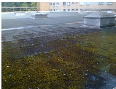
*La prolifération de la végétation sur une étanchéité autoprotégée et inaccessible laisse infiltrer l'eau pluviale dans la dalle en béton*
