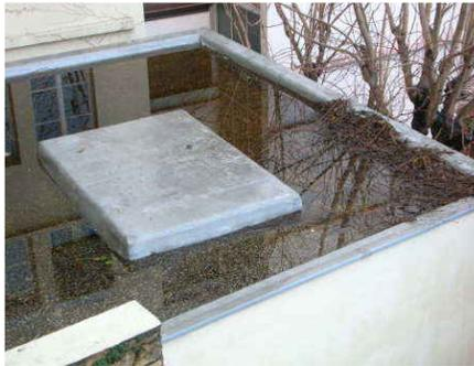
Une évacuation obstruée par des débris entraîne une flaque d'eau pluviale d'où une surcharge sur la dalle en béton.
