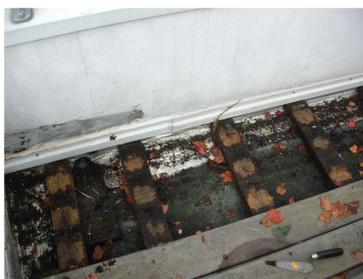
*Pose des lambourdes sur le complexe d'étanchéité autoprotégée risque d'endommager les membranes.*
