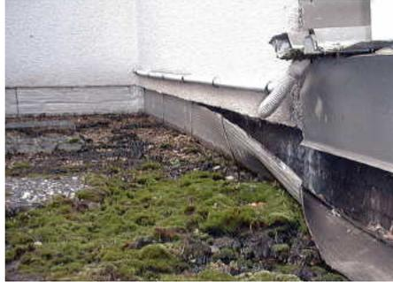
Décollement des relevés d'étanchéité entraîne immédiatement une infiltration d'eau au niveau de la dalle en béton.
